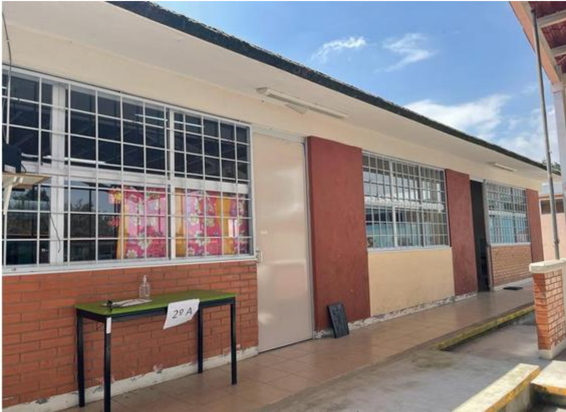
Figura 3. Infraestructura Institucional, se observa la dirección y el salón de tercer grado, grupo "C".
