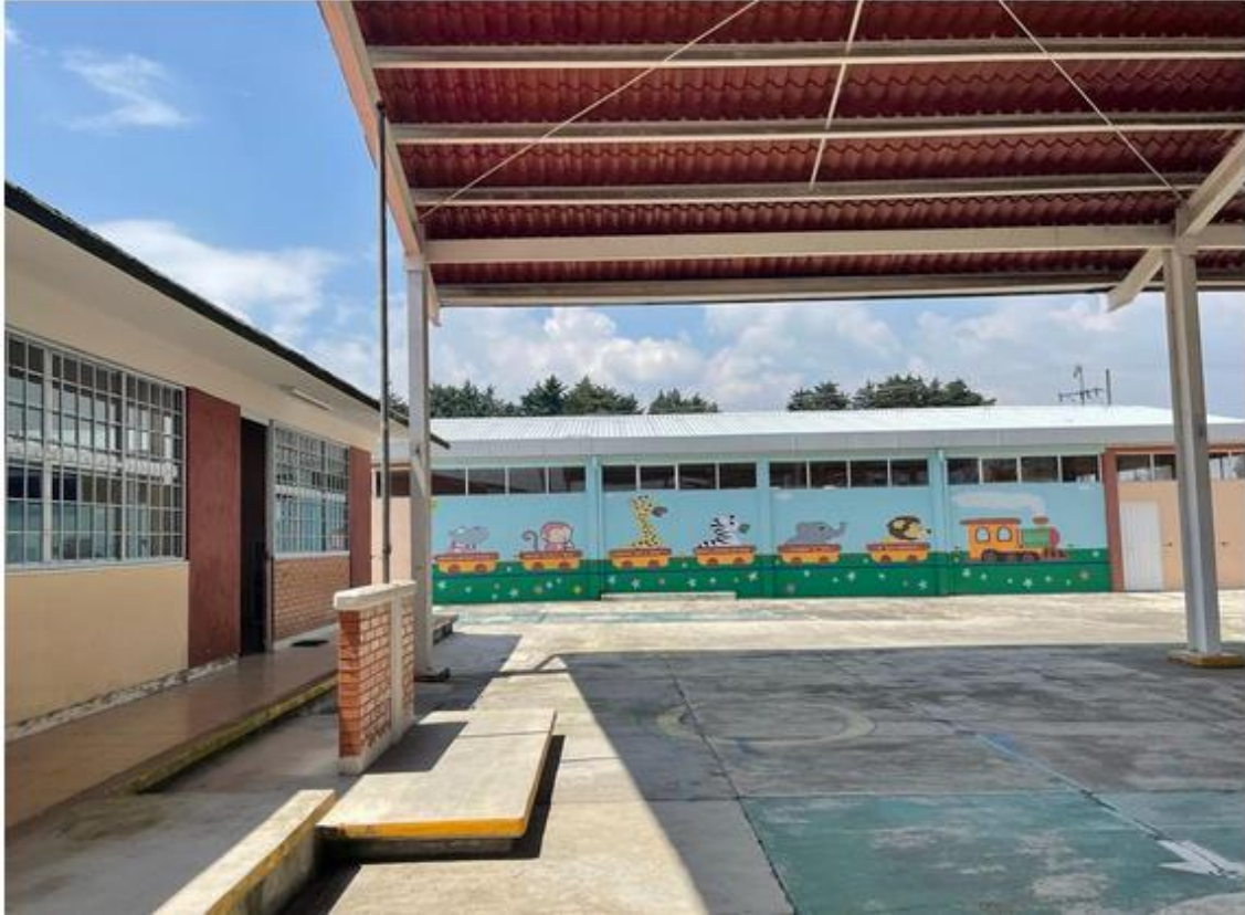
Figura 2. Infraestructura del Jardín de Niños Lázaro Cárdenas.
