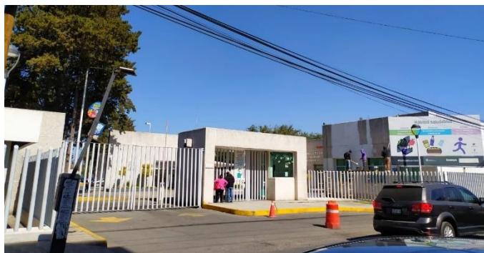
Figura 4. Fachada de la clínica particular CIDECO. Fotografía tomada por Carmen Yaritza Reyes Carrillo, el día 14 de enero de 2022.
