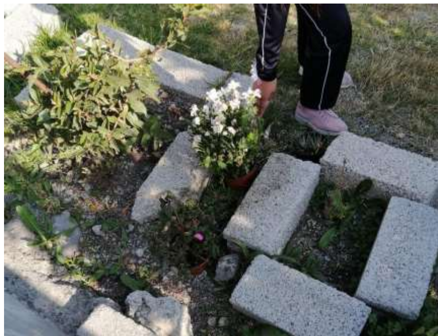
FIGURA 4. Rehabilitación de jardineras.
