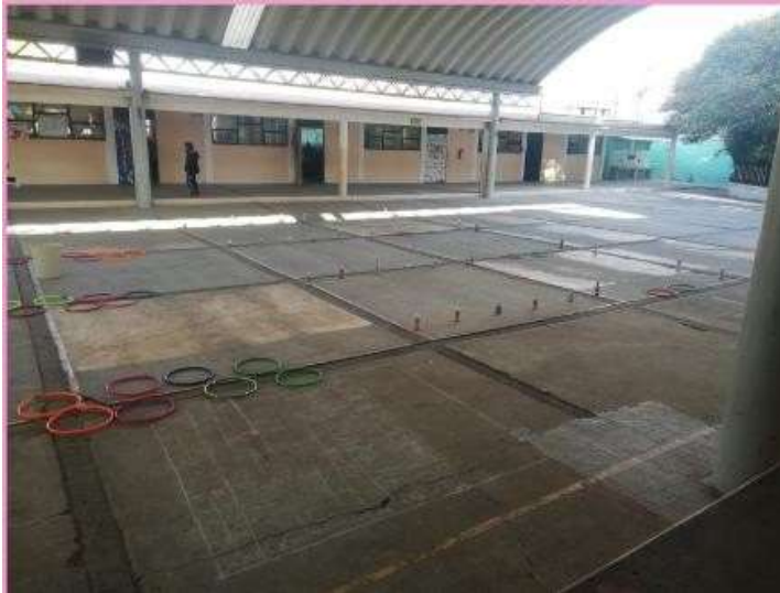
Patio de la escuela con materiales
