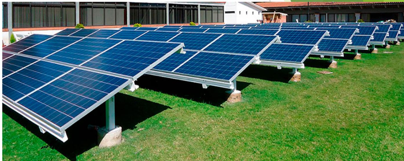
Para abastecer esa cantidad de energía se requieren aproximadamente 4,305 paneles solares, y un área disponible aproximada de 1.614 hectáreas; mientras que la potencia instalada sería de 1.03 MW.
