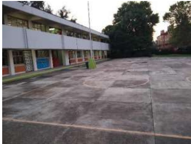
Imagen 1. Infraestructura de uno de los edificios de la escuela secundaria.
