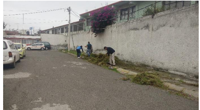
Imagen 3. Jornada de rehabilitación fachada trasera
