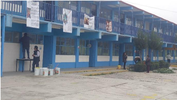
Imagen 2. Jornada de rehabilitación edificio escolar
