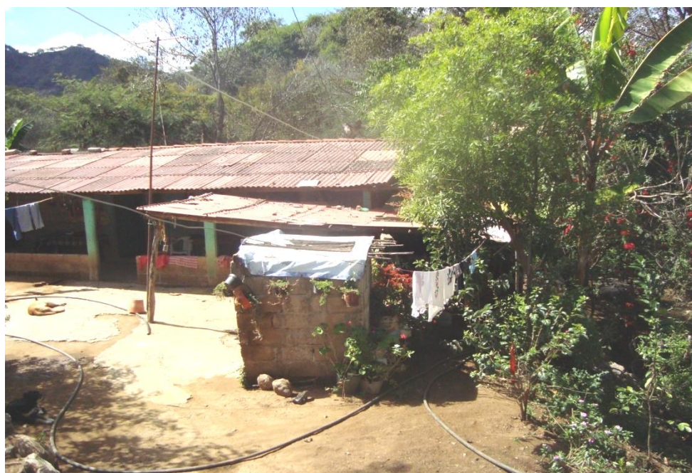
Vivienda con techo de lámina en Rincón de Rodríguez.
