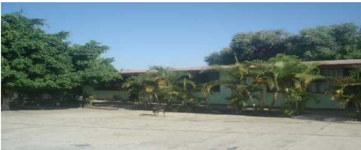
Ilustración 7. Aulas de la Escuela Primaria "Ignacio M. Altamirano". El Potrero de Tenayac, Temascaltepec, México.
