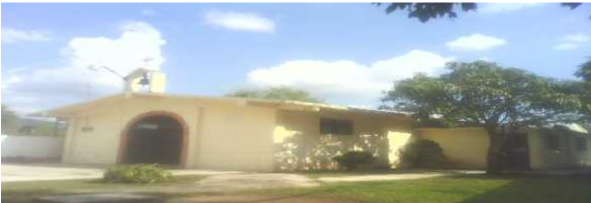
Ilustración 5. Capilla del Potrero de Tenayac desde 1978. Monumento histórico de ese lugar
