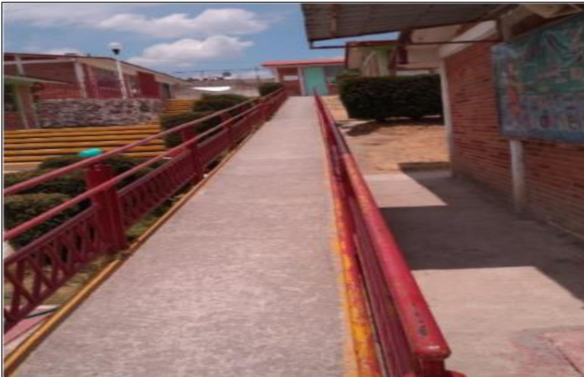
Anexo 8 Rampa para llegar a los cuatro niveles
