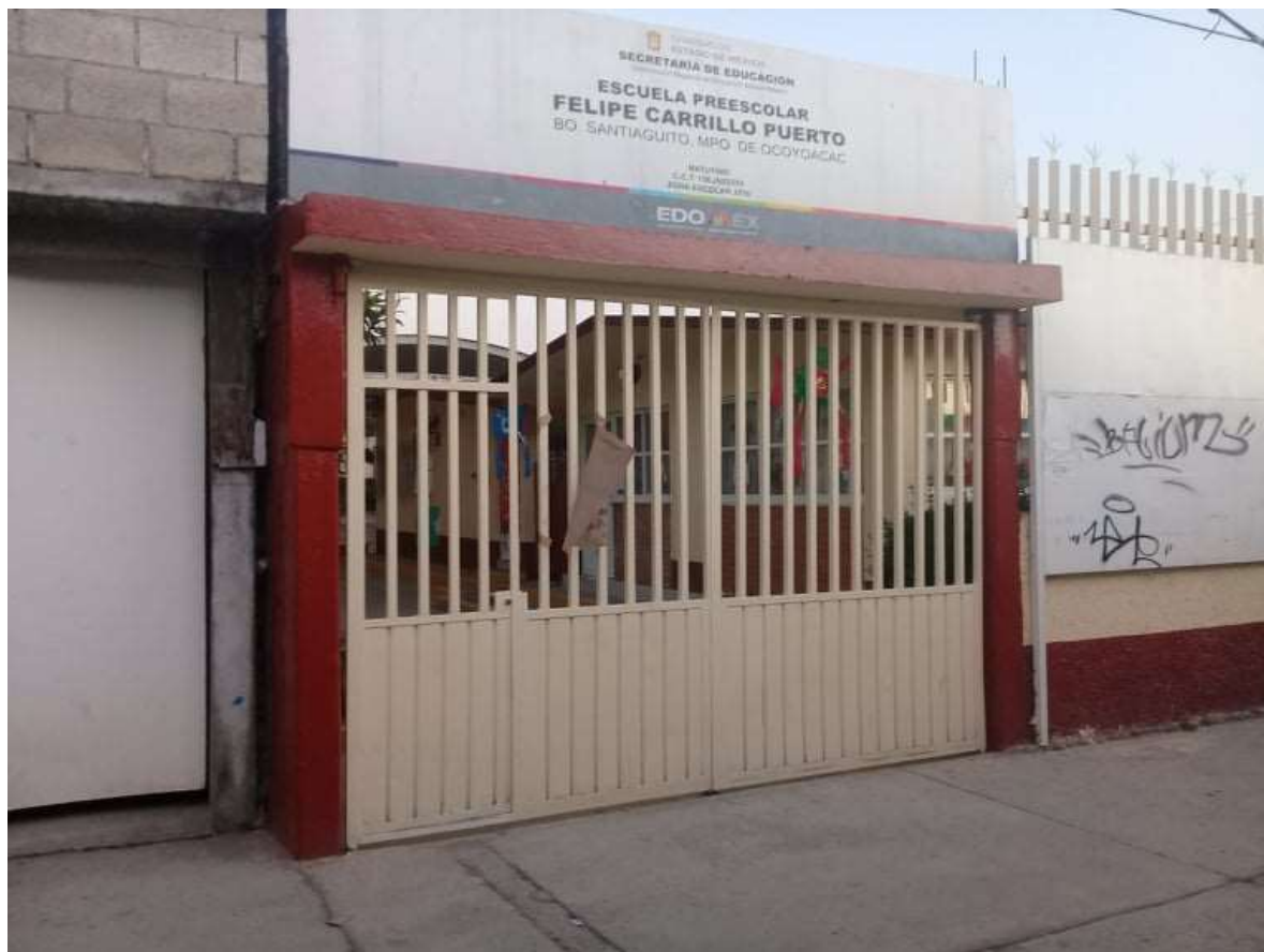
Figura 4. Fotografía de la entrada al Jardín de Niños “Felipe Carrillo Puerto”, ubicado en el Barrio de Santiaguito, Ocoyoacac, fuente propia, noviembre 2019.
