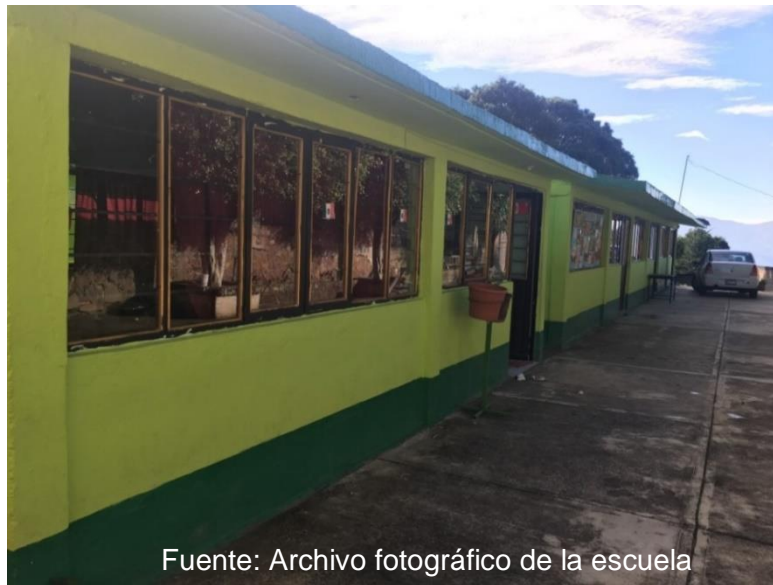
Fotografía No. 8 Características de las aulas
