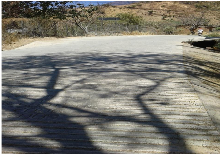
Tramo de carretera de concreto hidráulico: San Mateo – Santa María.
